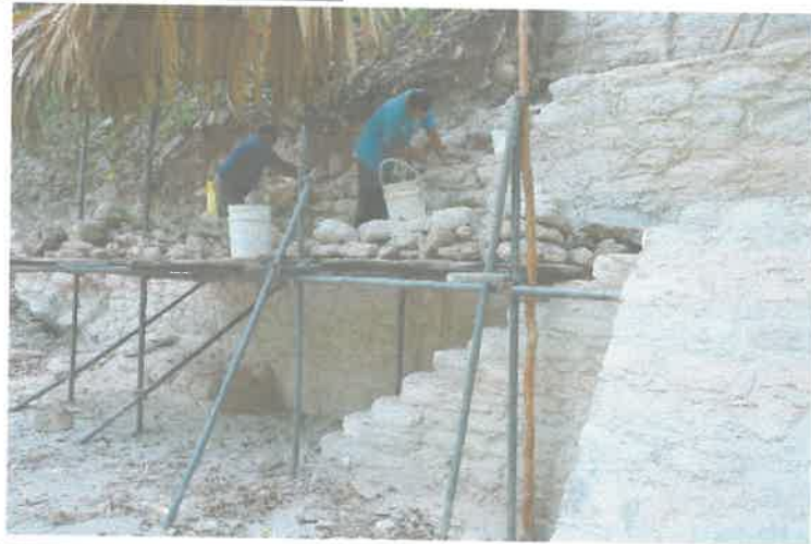
Trabajos de restauración de la fachada oeste de la estructura B.17. Fotografía Livni Almira, 2021.
