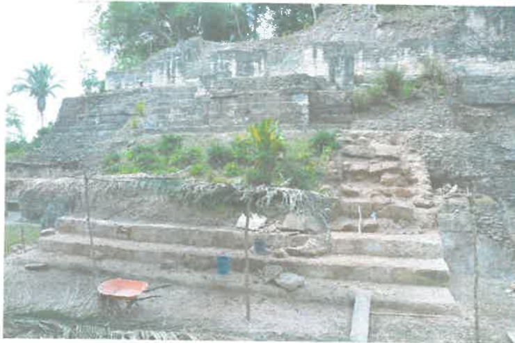
Trabajos de liberación de escombros y restauración de la escalinata principal de acceso de la estructura B.14. Fotografía Livni Almira, 2021.
